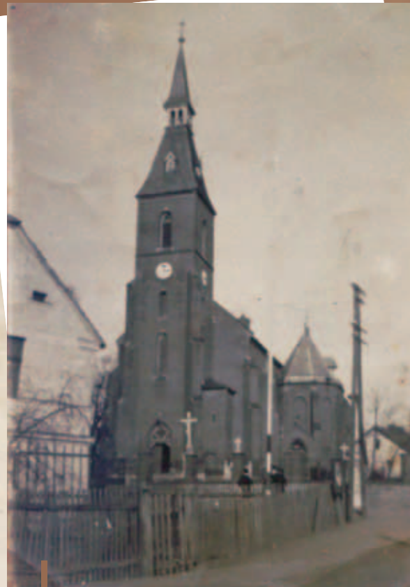
Widok kościoła parafialnego. Ansicht der Pfarrkirche.
