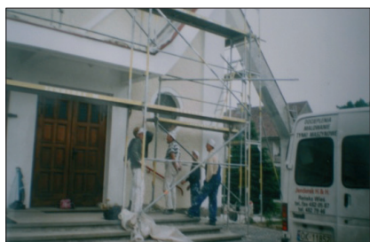
Tynkowanie nowego kościoła.
